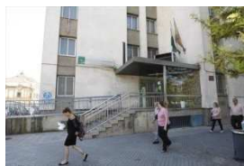
Antiguo centro de especialidades de Avenida de América. - A.J. GONZÁLEZ
